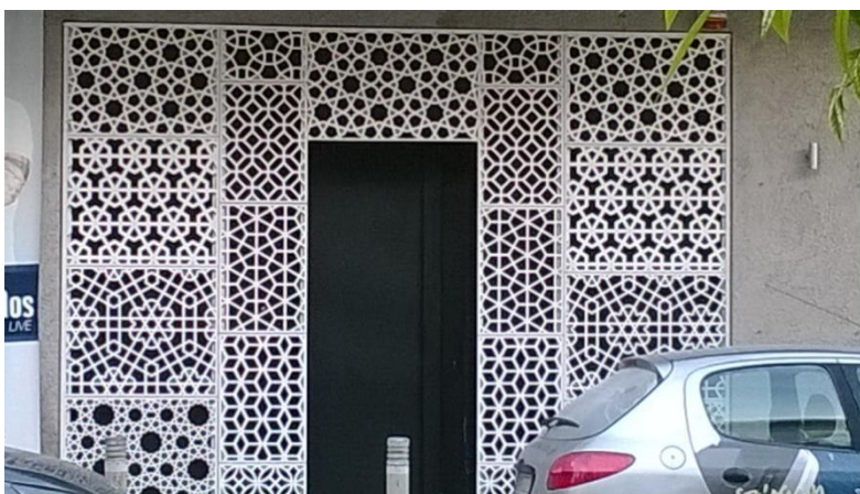
Εικόνα 8: Πρόσοψη κτιρίου. Οδός Αγίου Ανδρέου Πάτρα.
